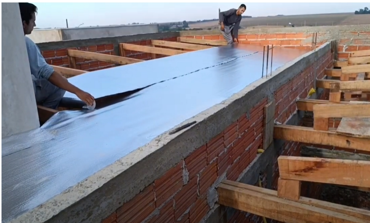
Figura 5. Instalação de manta de subcobertura
