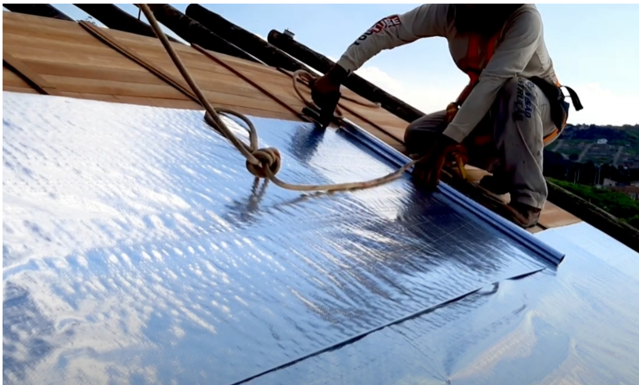
Figura 16. Fixação da manta de subcobertura.
