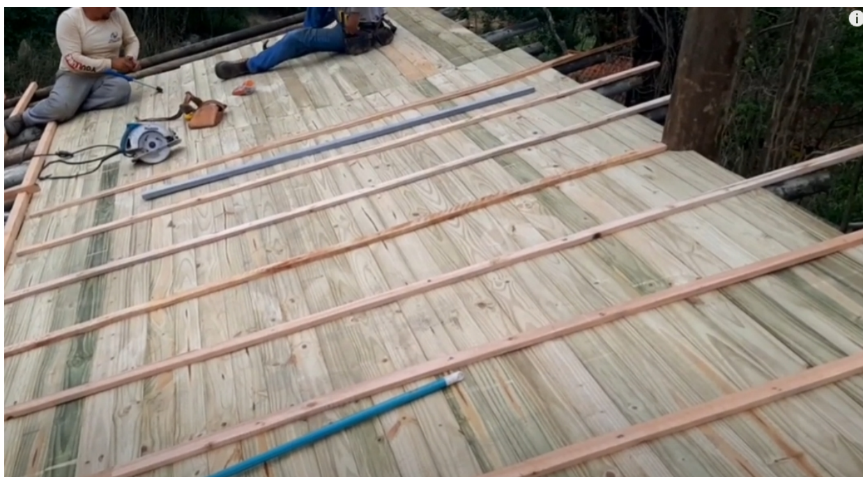
Figura 15. Detalhe do contracaibro.
